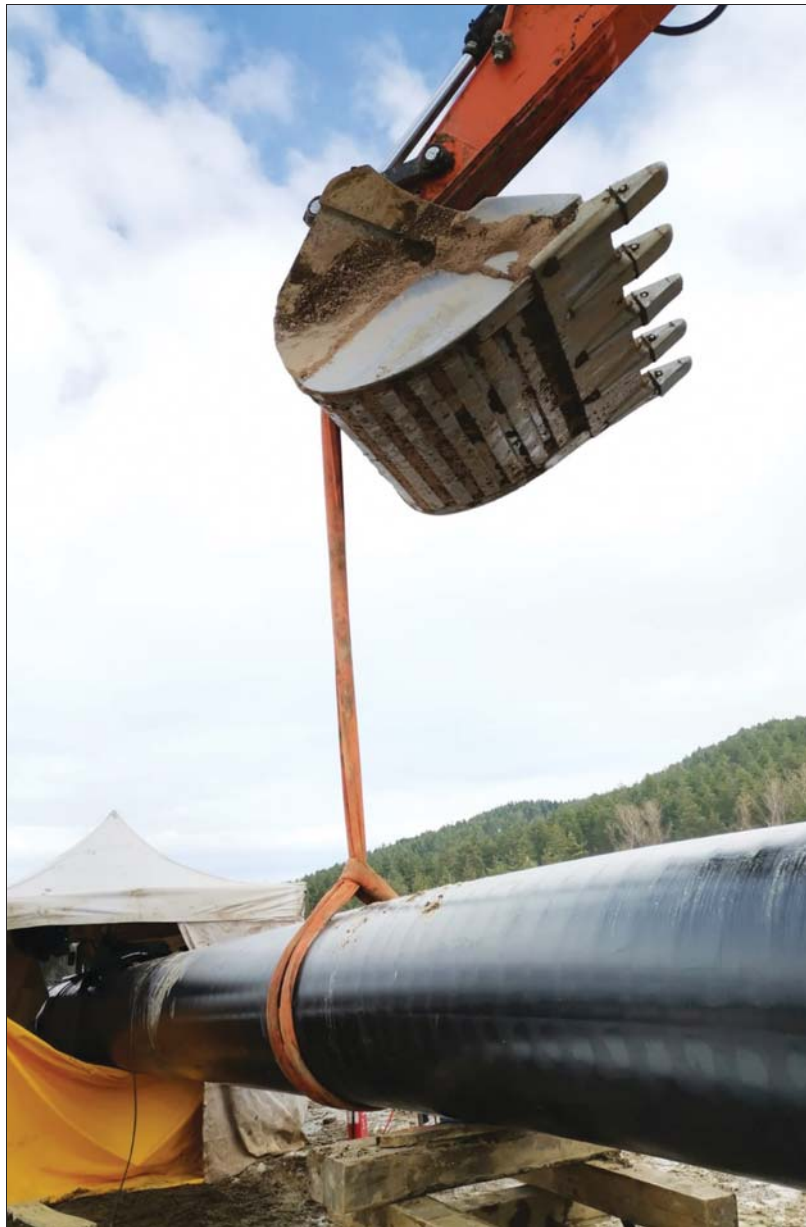
Газовата връзка с Гърция, която сега се строи, ще се свърже с газопроводите към трите въглищни централи в Маришкия басейн.
